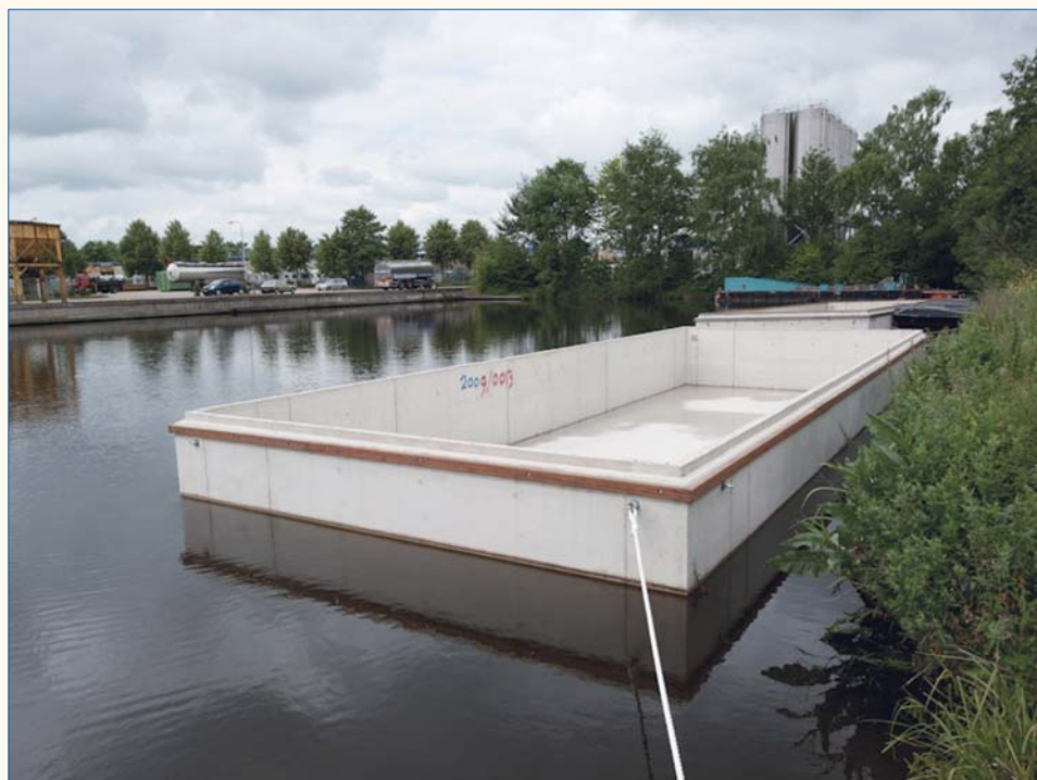
Het eindresultaat: een perfect betoncasco.
