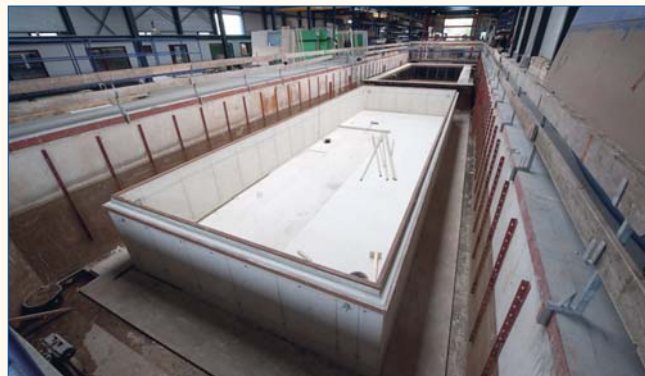
Het grootste deel van de betonnen bakken is bedoeld als fundering voor woonarken of watervilla's.
